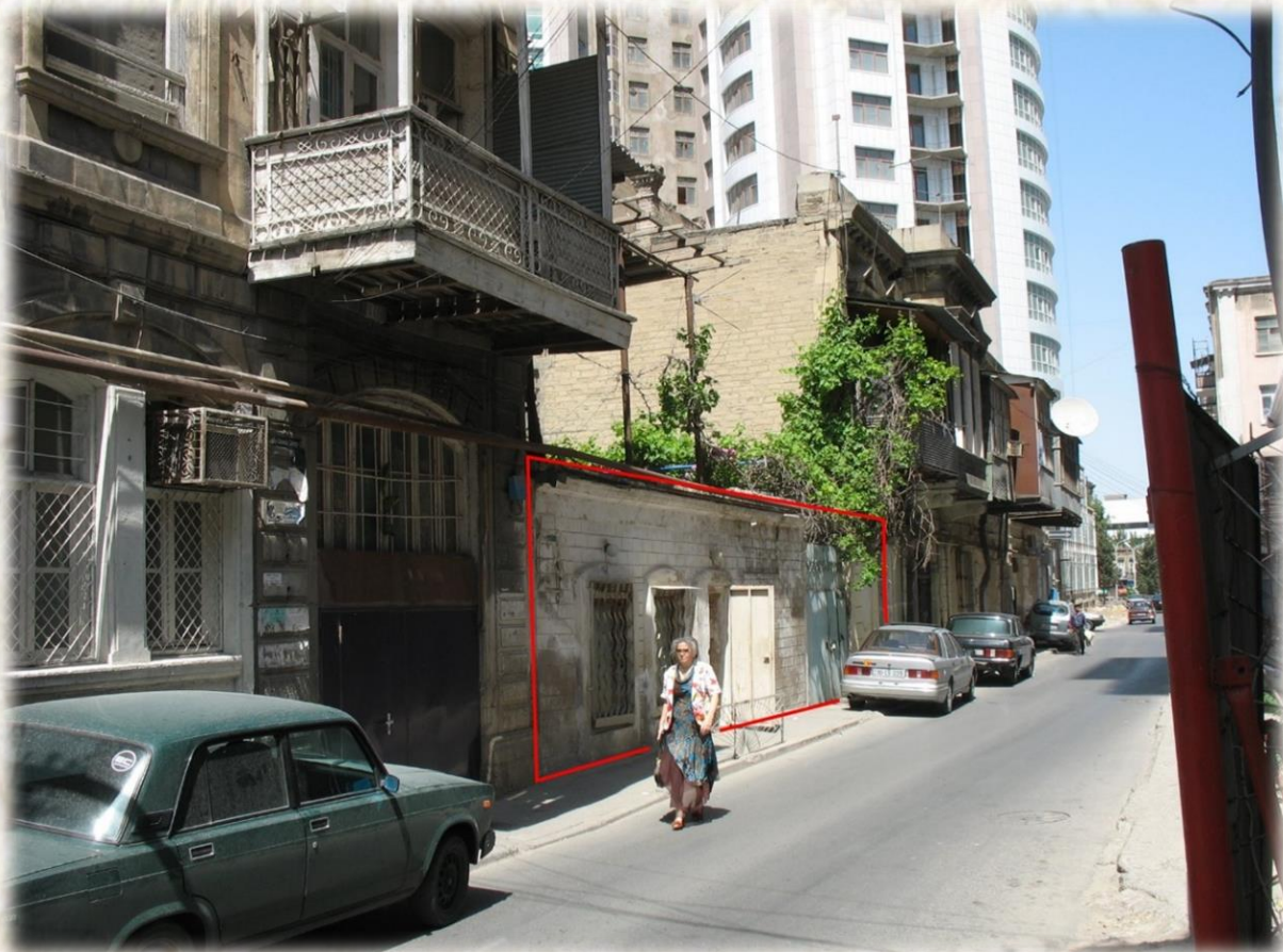
Наружная часть дома, в котором в 1943-1945 гг. снималась квартира под ашкеназскую синагогу.
